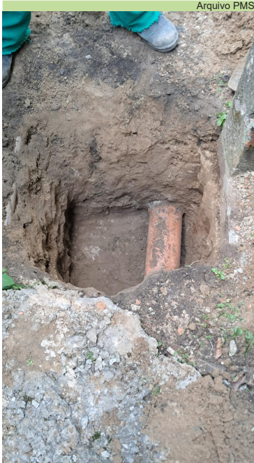
Confecção de caixa de esgoto na lateral do prédio da Prefeitura Regional
