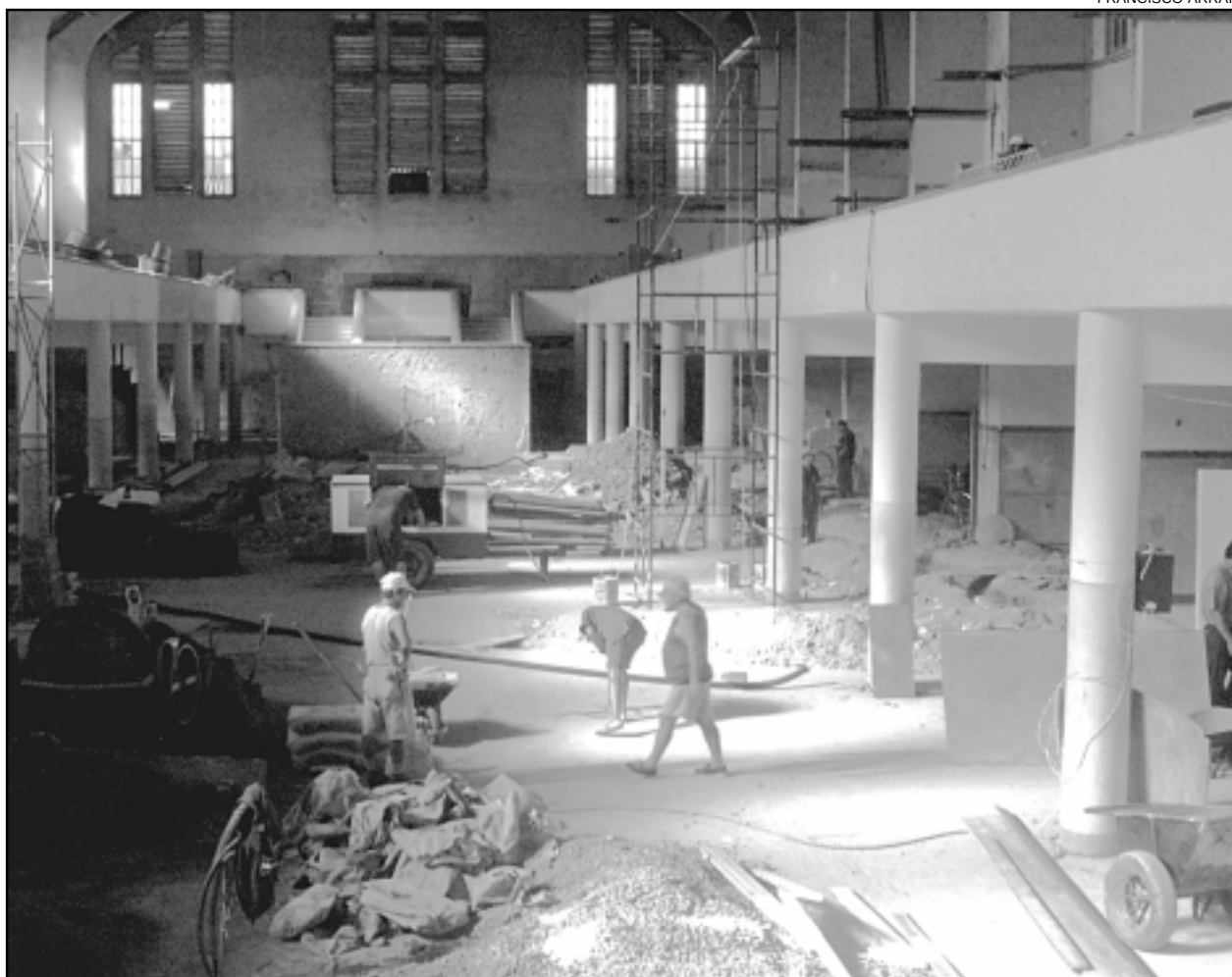
Conclusão dos serviços está prevista para o mês de agosto
