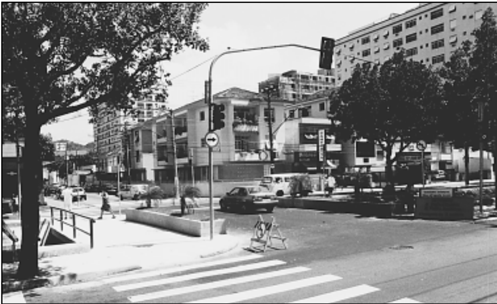
Obra - A ponte foi construída no alinhamento da Rua Carlos Gomes
