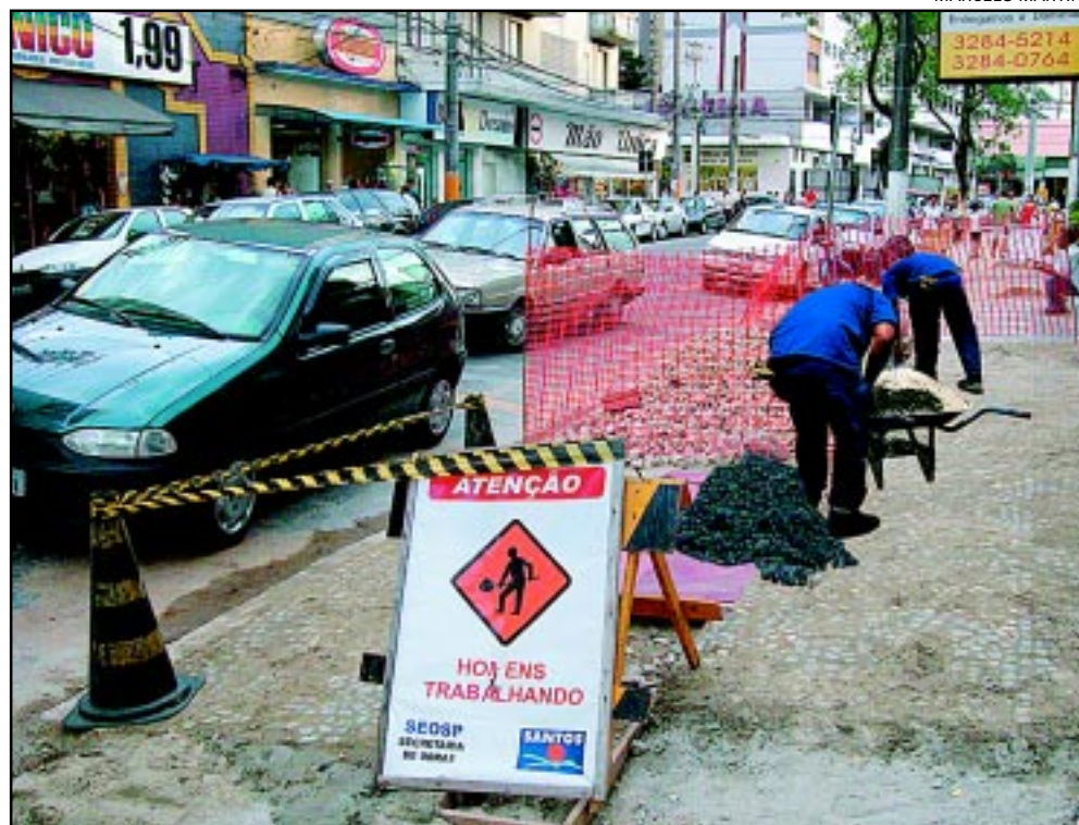
Intervenção renova a infra-estrutura urbana no Gonzaga
