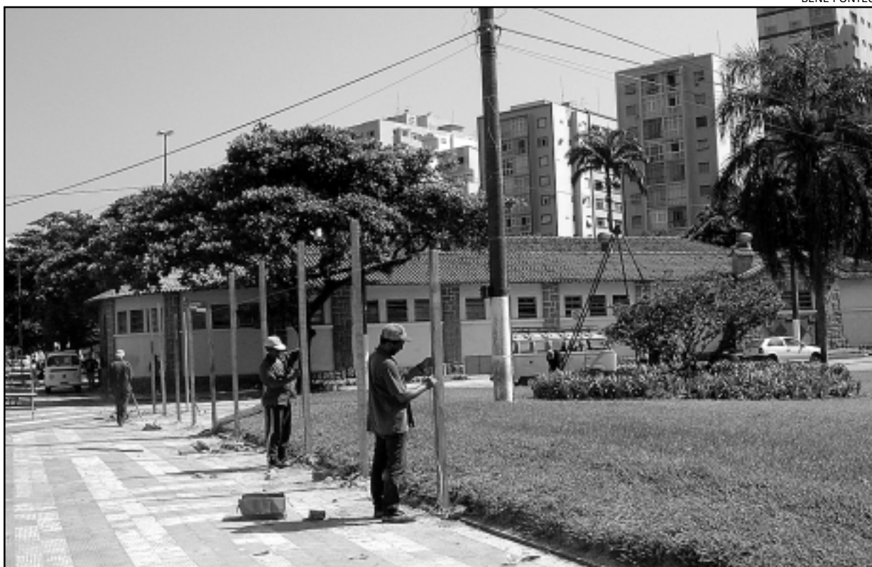
Obras de ampliação do equipamento têm previsão de duração de 12 meses
