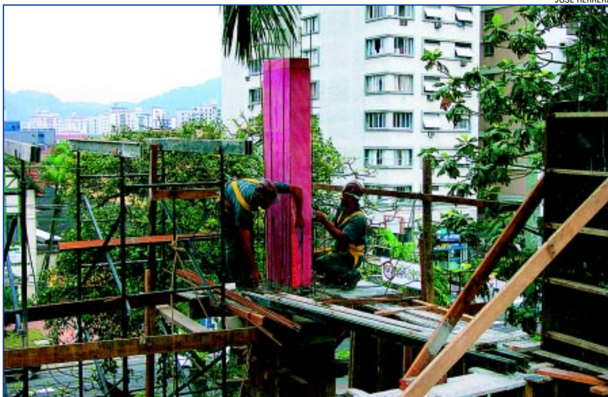
Cerca de 30 operários executavam, ontem, os mais variados tipos de serviços no posto
