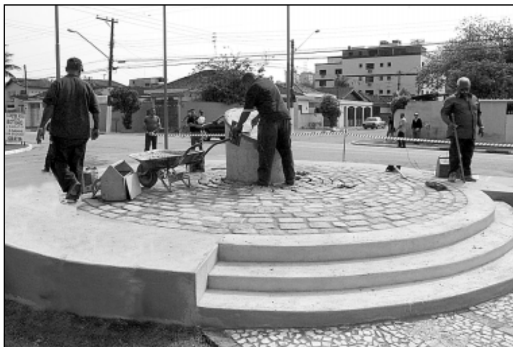
Obra é realizada pela Secretaria de Obras e Serviços Públicos da Prefeitura
