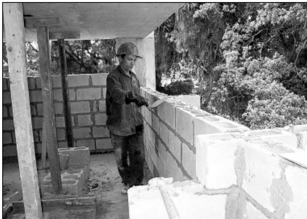
Serviços realizados pelas equipes seguem a pleno vapor
