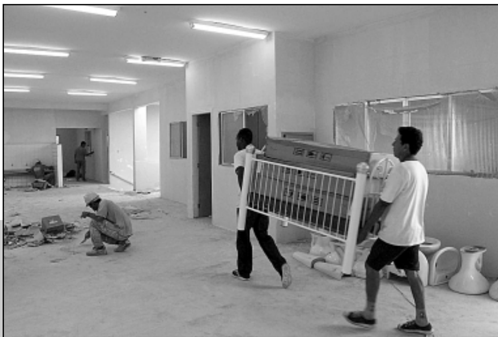
Funcionários dão os últimos retoques na obra e montam o mobiliário
