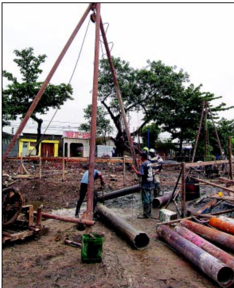
Serviços são realizados em uma área de 1.480 m 2
