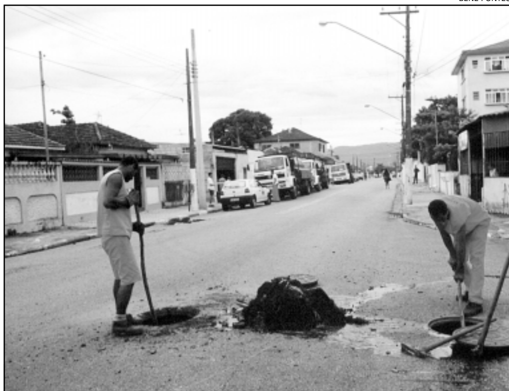
A limpeza do sistema de galerias faz parte dos diversos serviços efetuados sistematicamente
