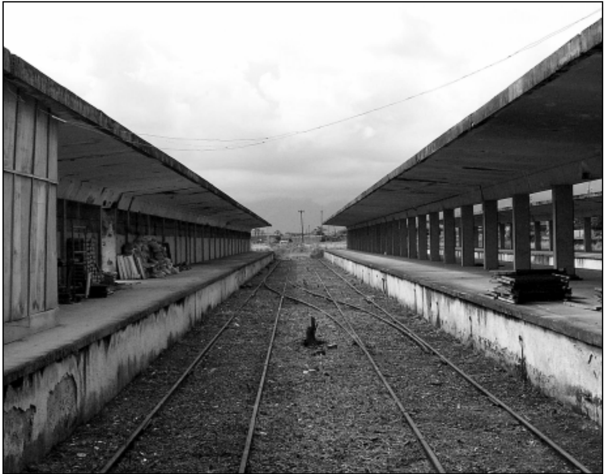
Serviços serão iniciados com a demolição das antigas plataformas
