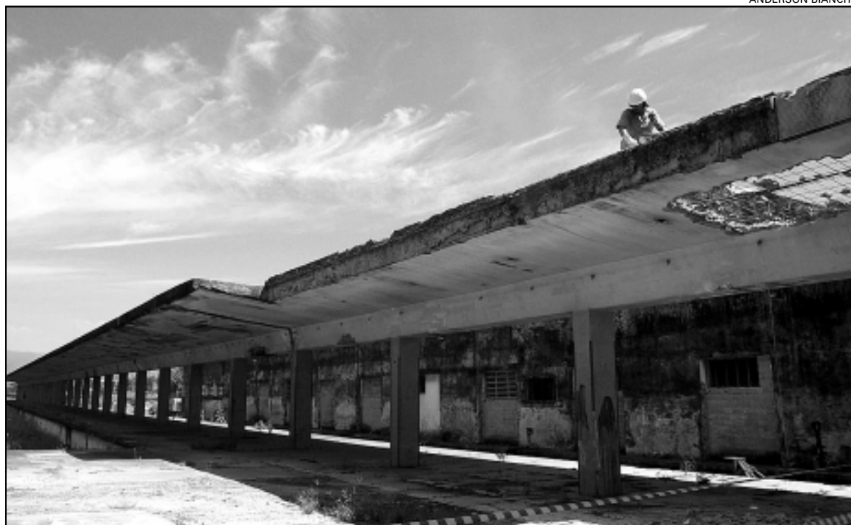
Trabalhos, ontem, incluíram demolição de parte de uma das plataformas de embarque de passageiros
