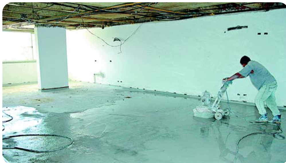
Serviços estão mais avançados no 1º e 2º pavimentos, onde funcionários tratam do piso e pintam paredes
