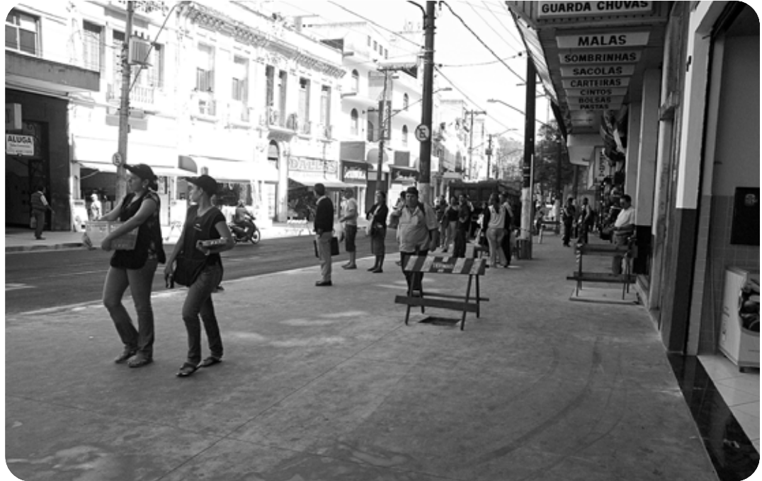
Obras seguem padrão dos passeios junto aos canais
