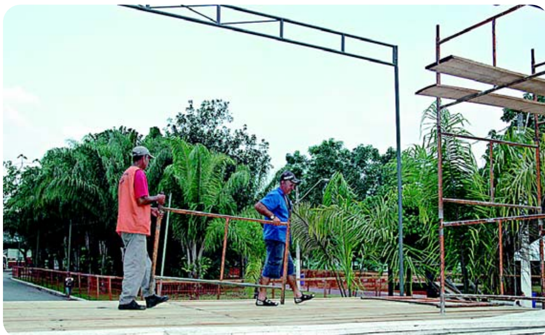
Montagem da estrutura do evento que contará com palco para shows e 23 tendas para venda de doces e artesanato
