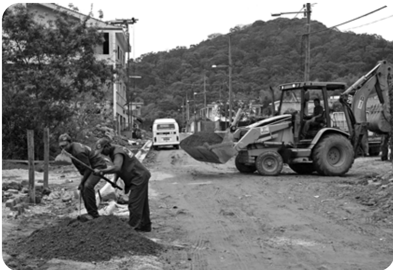
Travessa Maria dos Reis está sendo preparada para receber camada asfáltica
