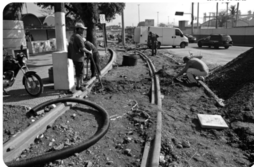
Depois da colocação de guias, funcionários nivelam a pista, que em seguida será asfaltada
