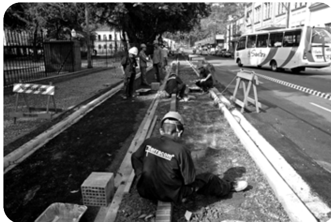
Pista exclusiva para ciclistas, na Praça dos Andradas, recebe asfalto
