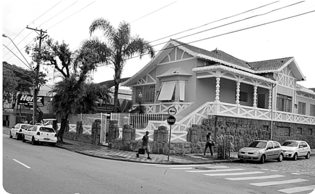
Unidade agora funciona em uma casa reformada e adaptada pela prefeitura na Avenida Conselheiro Nébias, 325
