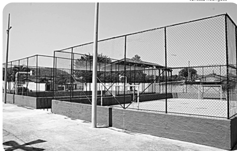
Os equipamentos dispõem de novo sistema de iluminação, alambrados e redes de contenção
