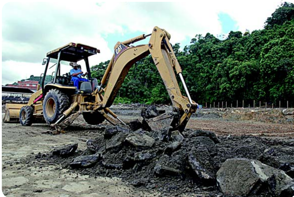
Prefeitura começou as obras no terreno da Vila Mathias em fevereiro com nivelamento de terreno e início das fundações
