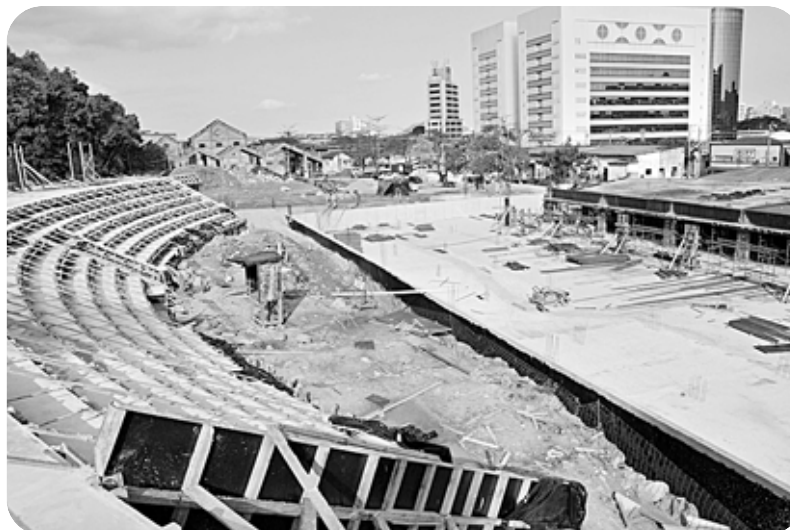
Parte da arquibancada, primeiro e segundo pavimentos demonstram avanço da obra
