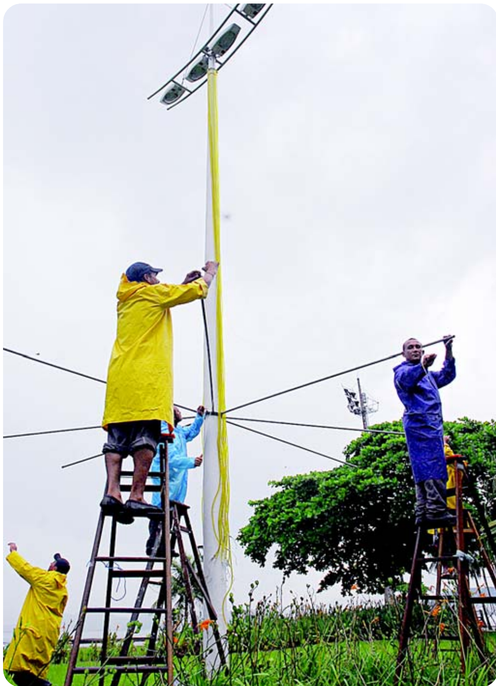
Funcionários da prefeitura montam estrutura estilizada no jardim da praia
