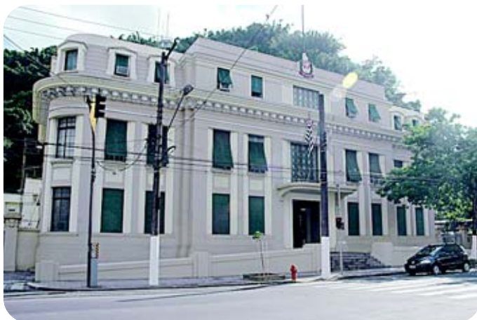
Edifício Saturnino de Brito, em estilo clássico, foi erguido em 1910
