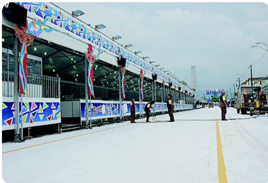
Funcionários dão os retoques finais na Passarela do Samba, onde as escolas começam a desfilar hoje
