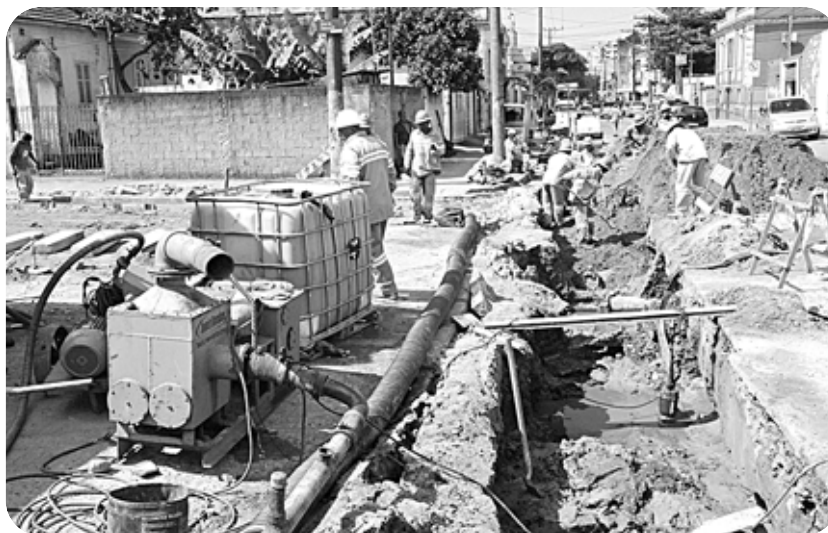
Serviços incluem pavimentação, construção de calçadas e instalação de postes de luz
