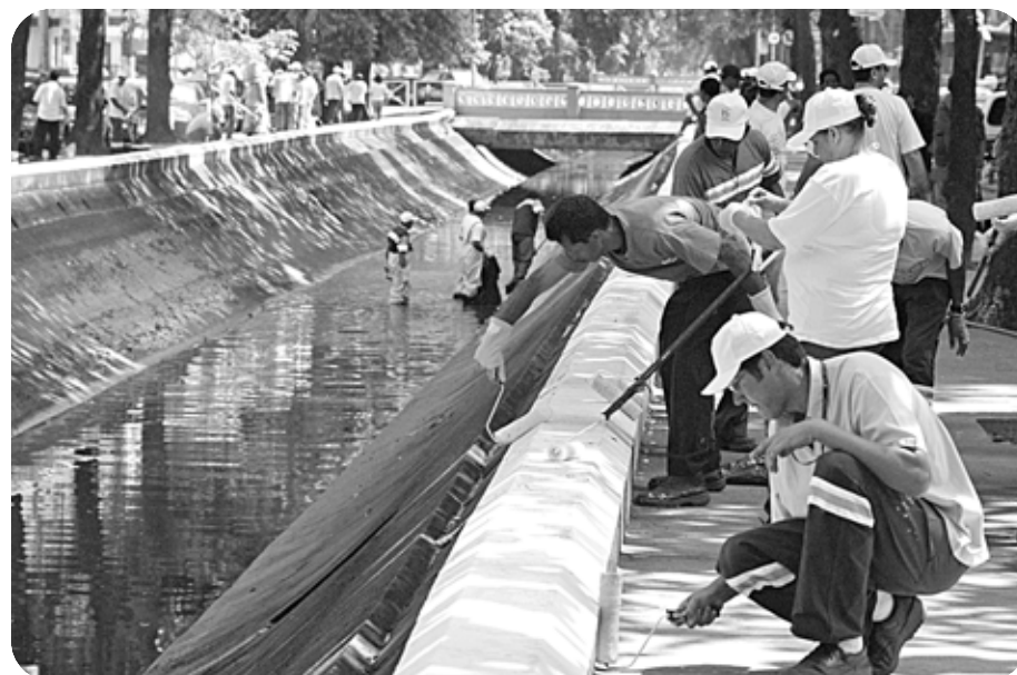
Demonstração de nova tecnologia foi acompanhada de mutirão de serviços de limpeza nos canais
