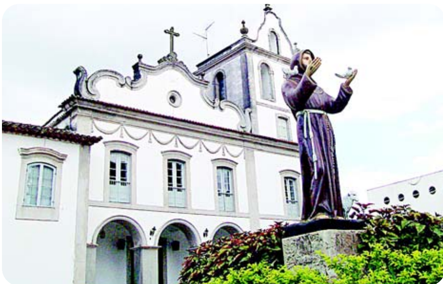
Fachada do Santuário de Santo Antônio do Valongo, construído por padres franciscanos
