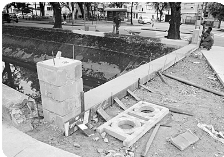
Na Avenida Ana Costa o serviço se concentra entre as ruas Espírito Santo e Pedro Américo; ao lado, obra na Pinheiro Machado
