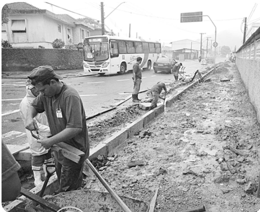
Ao lado do Conjunto dos Estivadores, calçada é renivelada para ganhar piso de concreto
