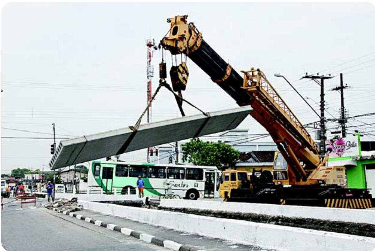
Guindaste içá laje para colocá-la sobre canal na Zona Noroeste, onde serão construídas quatro pontes
