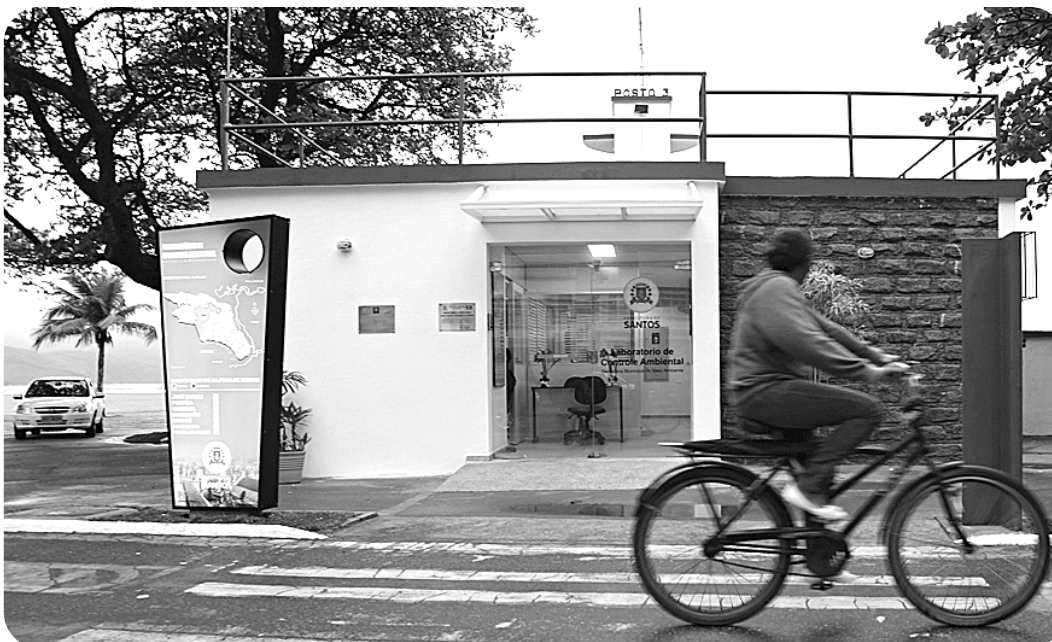
Totem em frente ao equipamento no Posto 3, no Gonzaga, indica condição de balneabilidade das praias
