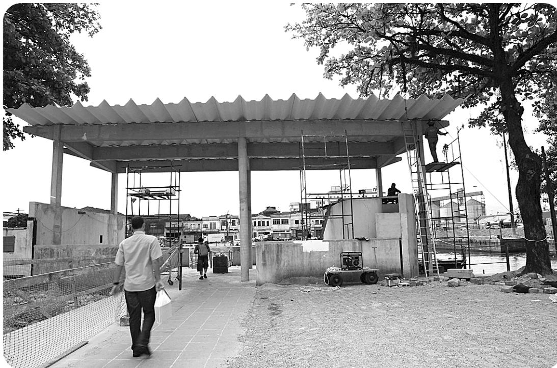
Novo telhado sustentado por pilares de concreto, em substituição à forma metálica que estava comprometida
