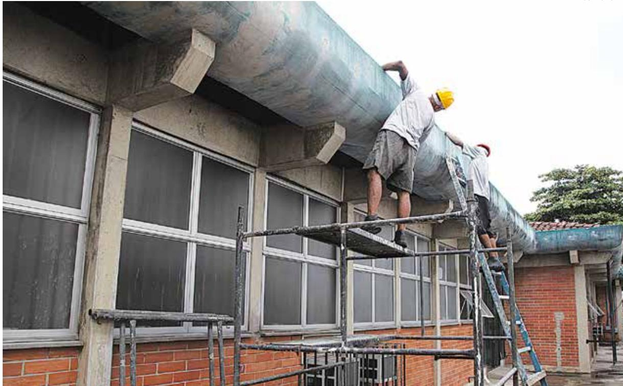
Intervenções começaram pela recuperação da cobertura, que exigiu a substituição de telhas quebradas e de calhas
