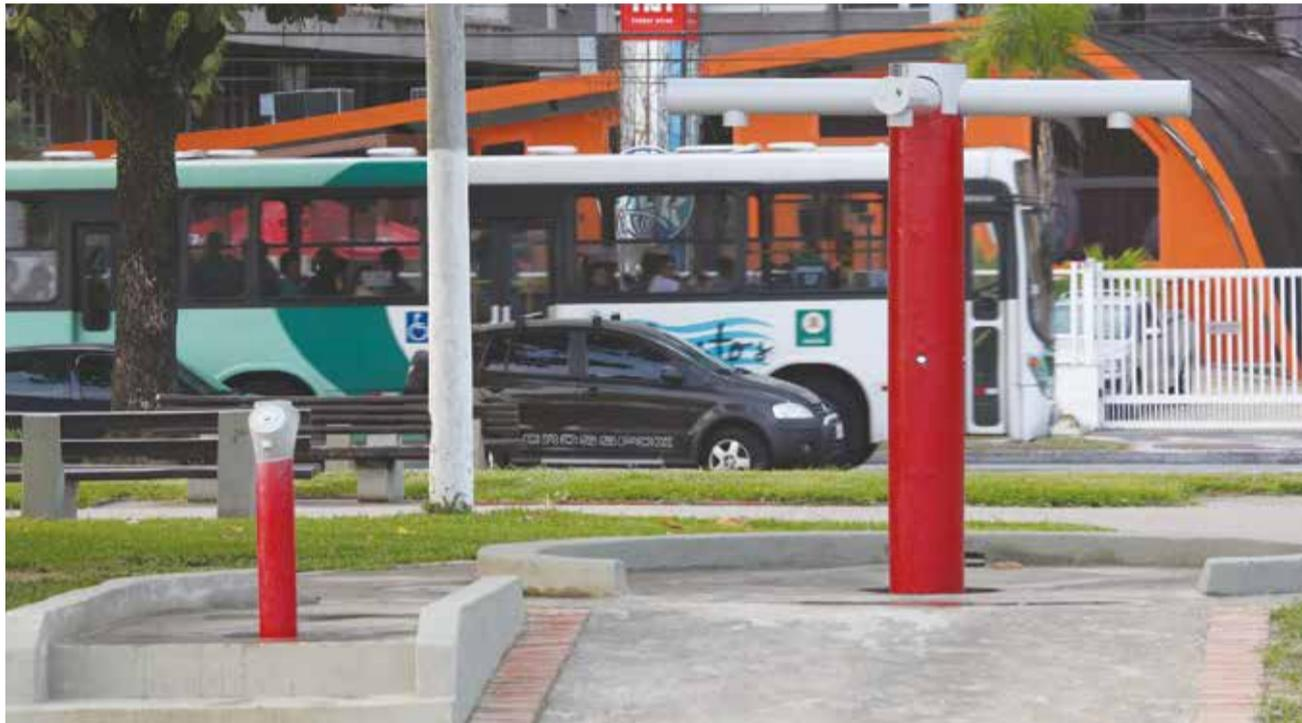
Módulo (à esq.) tem 1,20 m de altura, 15 cm de diâmetro, e esguicho direcionado para evitar desperdício de água
