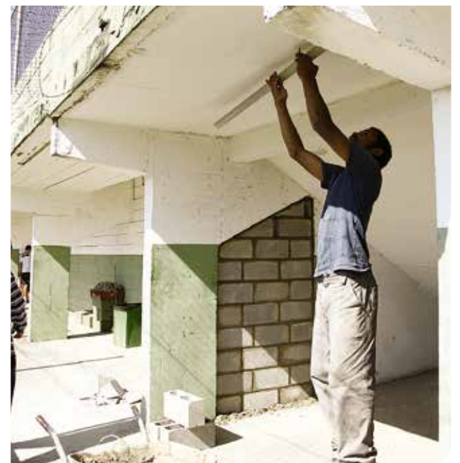
Trabalhos estão centrados na estrutura das arquibancadas
