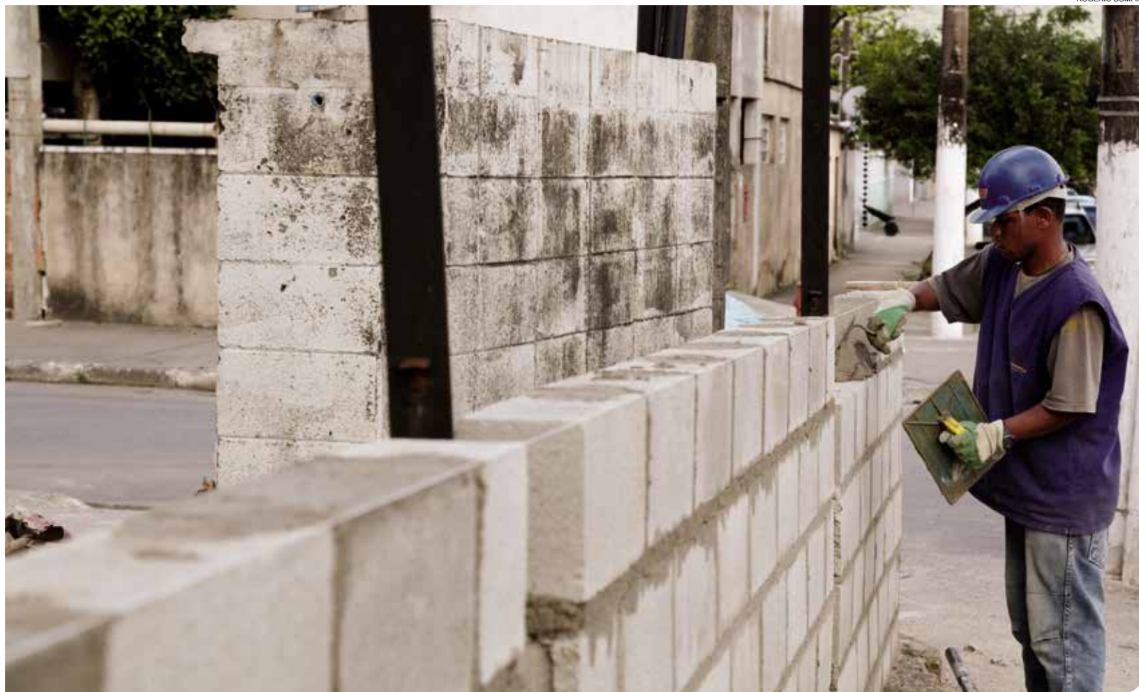
Operários constroem o muro lateral de blocos de concreto e estão trocando o gradil situado na parte frontal da unidade
