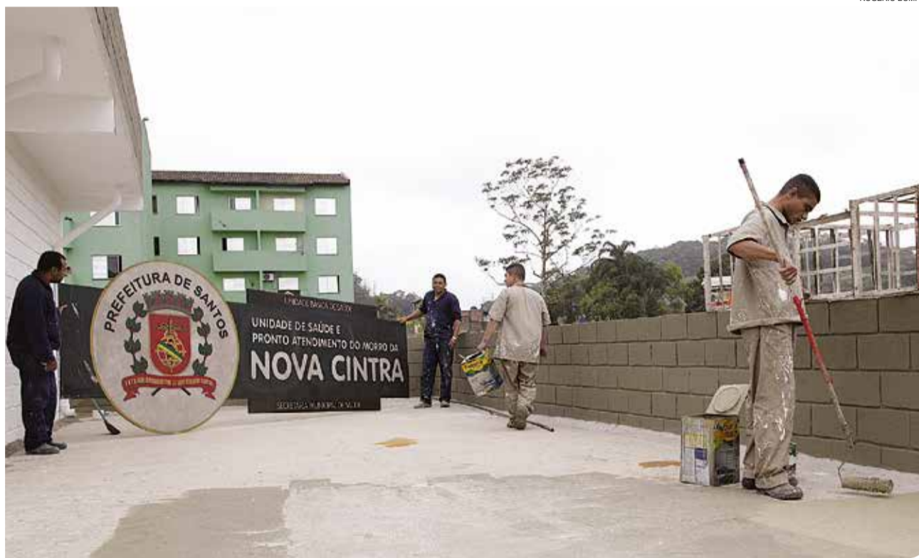
Em virtude dos trabalhos de pintura na parte interna, a unidade permanecerá fechada no sábado e domingo
