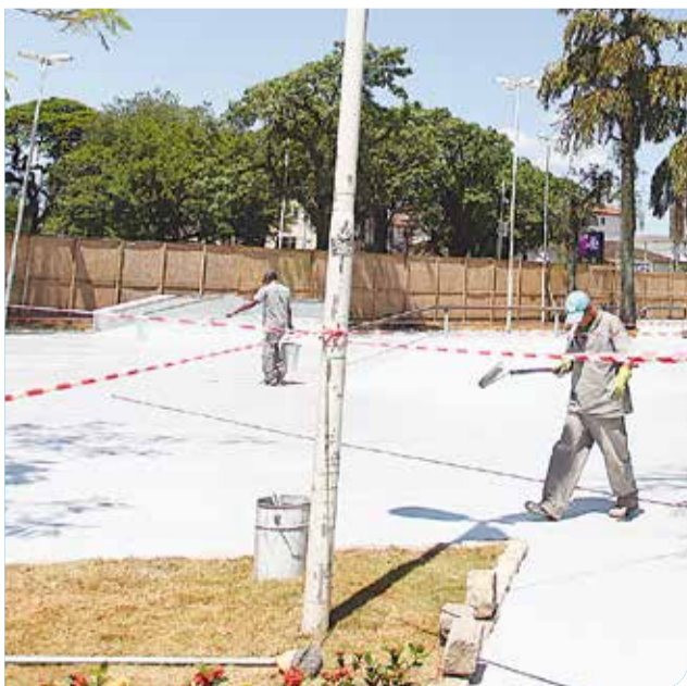
Serviços no local incluíram a recuperação de rampas
