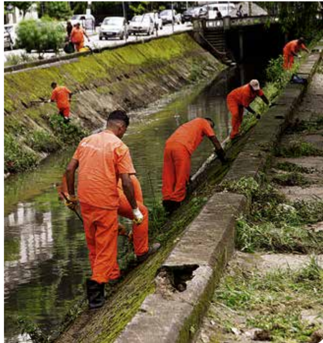
Operários também retiram lama, lixo e entulho do canal
