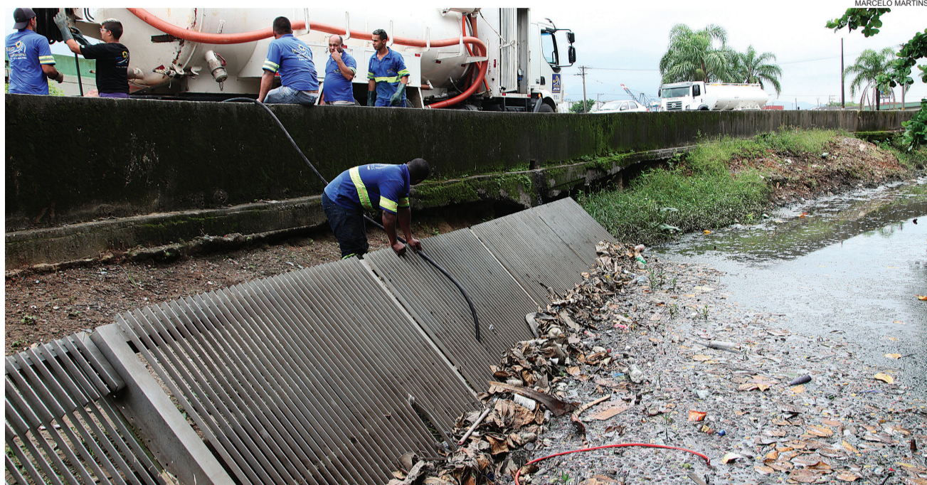
Retirada de lixo e desassoreamento de tubulação alivia sistema de drenagem ao permitir a condução das águas
