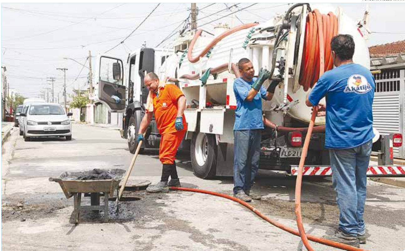
Equipe da Prodesan remove detritos de galeria com auxílio de caminhão hidro-jato que faz alta pressão
