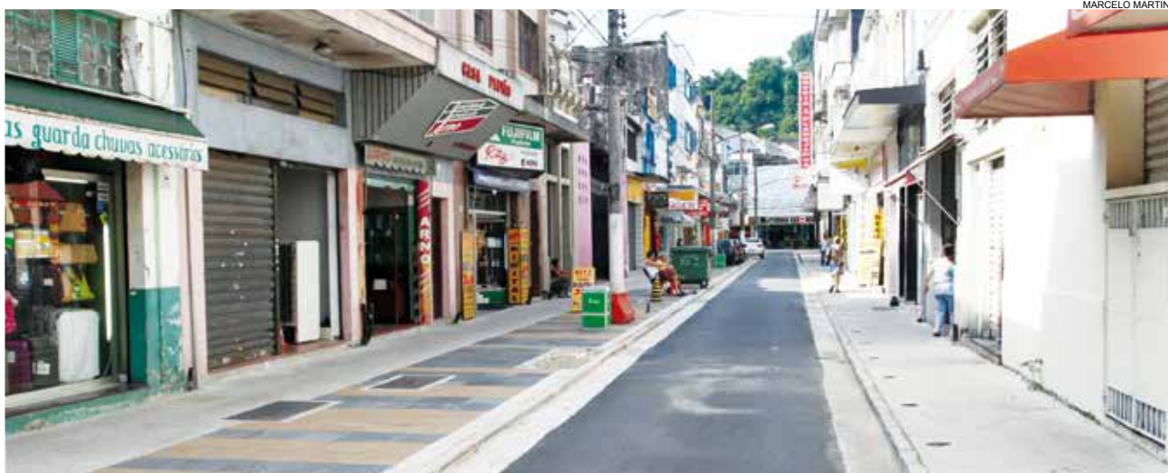
Próxima etapa de serviços na via da região central será com implantação do paisagismo e instalação de bancos e luminárias
