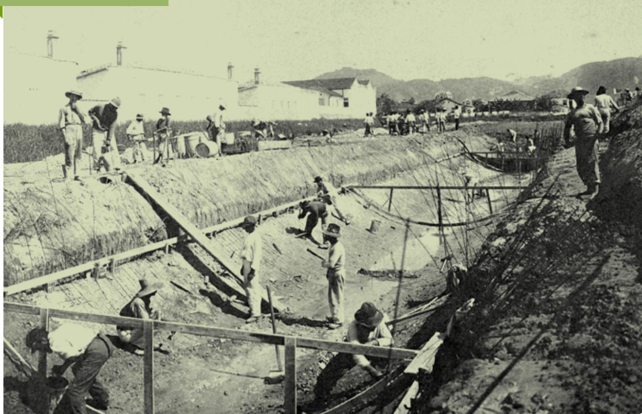
A imagem mostra a construção de um dos canais em concreto armado, em 1906. Autor desconhecido.
