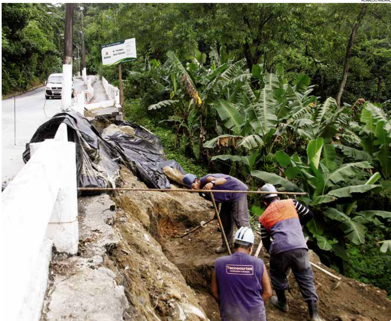
Na Alameda Prefeito José Gomes, operários executam segunda etapa da estrutura de contenção da encosta
