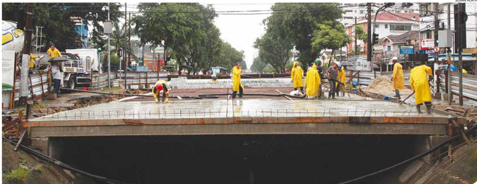
Após instalação de 21 placas de laje pré-moldada, equipes trabalharam na aplicação de 50 metros cúbicos de concreto para pavimentar a estrutura
