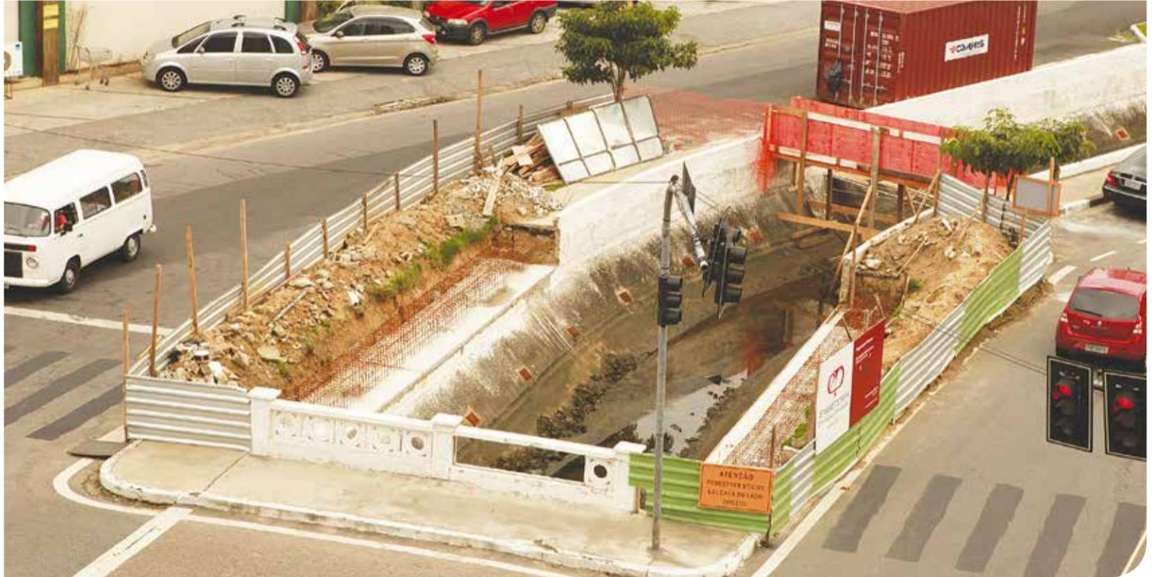
Berços para sustentar a laje já foram executados e a, partir de agora, será instalada capa de concreto para, em seguida, ocorrer o asfaltamento
