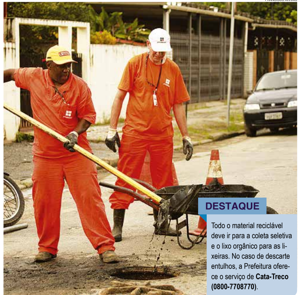
Equipes retiram de bocas de lobo papéis, sacolas plásticas, embalagens e garrafas
