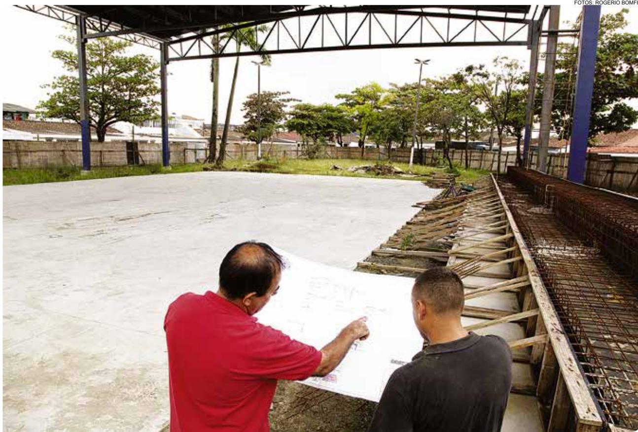
Com tratamento de estruturas metálicas, primeiras atividades estão concentradas em quadra poliesportiva
