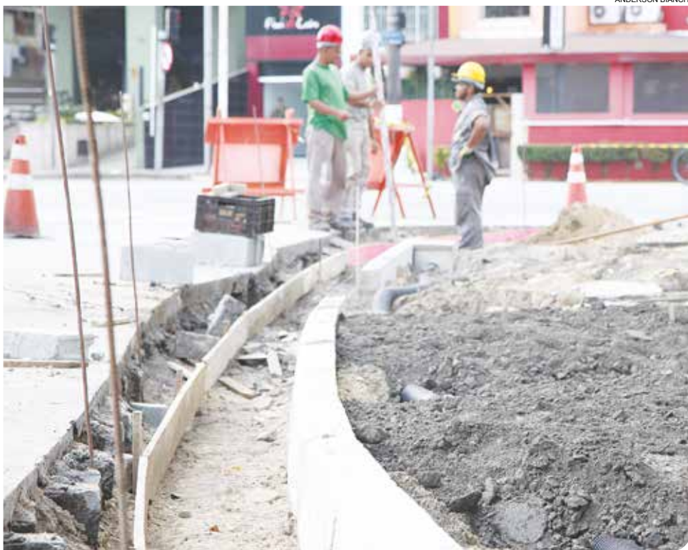
Operários estão refazendo as sarjetas e remodelando as guias em trecho da avenida
