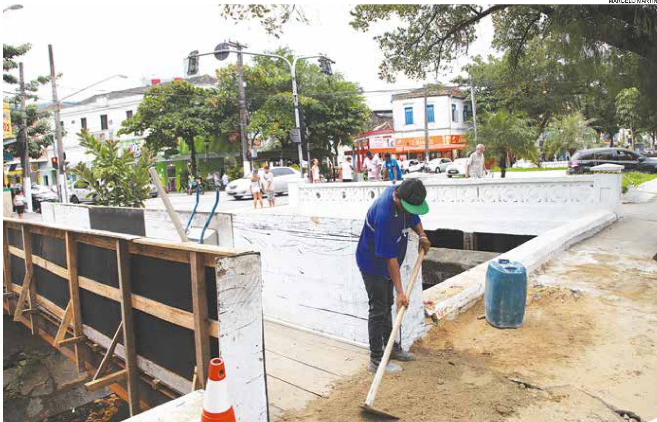
Em razão dos trabalhos, ponte provisória para utilização pelos pedestres é instalada na Av. Bernardino de Campos
