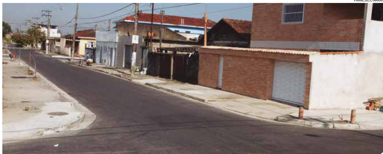
Obras do programa incluem drenagem, calçadas, raspagem do asfalto antigo e a nova pavimentação das ruas
